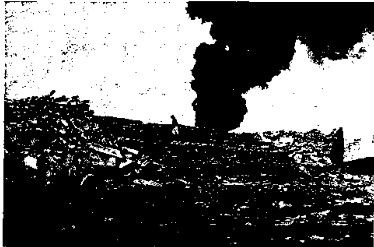
پلکان مجدد قدیم مسجد سلیمان در سال ۱۳۰۱ هجری که دیده می‌شود از چاه مجاور است که به نفت رسیده و گاز و نفت آن را در محوطه بی‌خطری می‌سوزانند تا آنکه بتوان آلات لازمه را بر سر چاه
