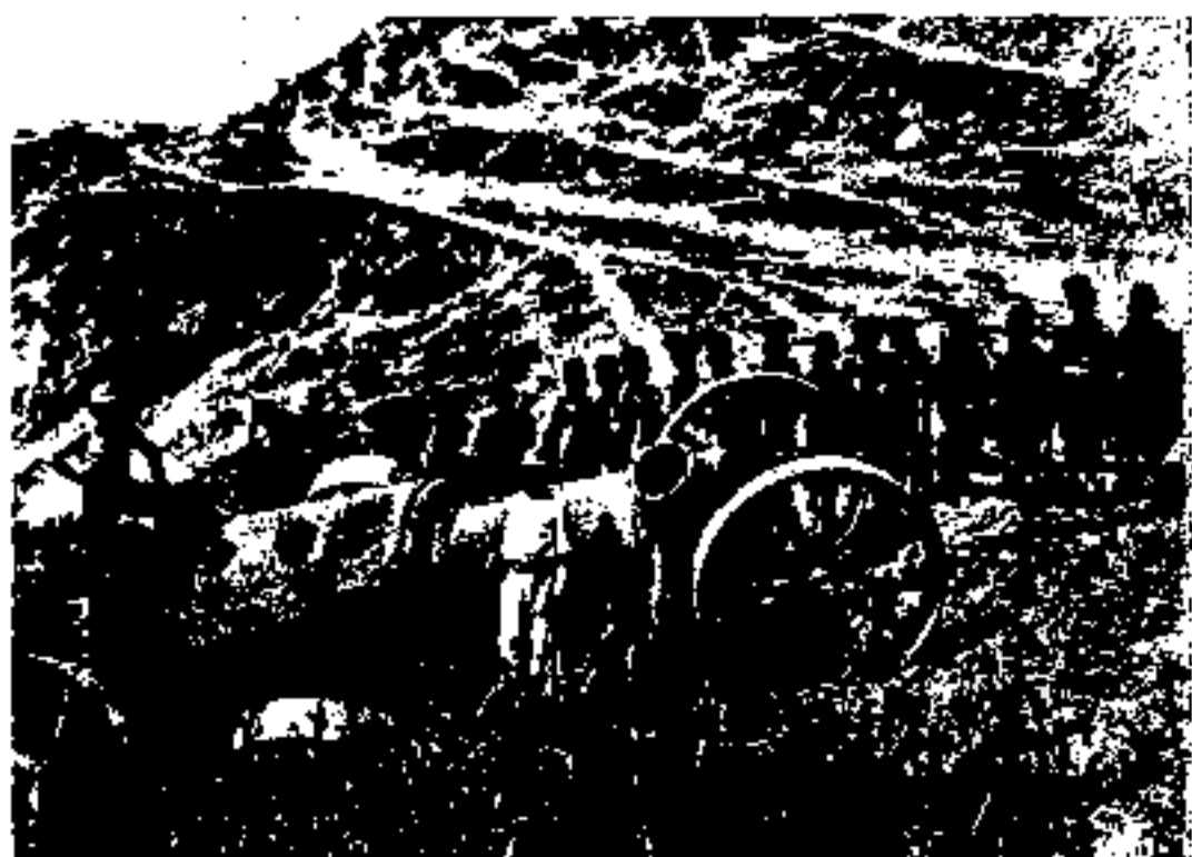
دبگ بخار چاه شماره یک که از میان کوهها و دشنها بوسیله لافتر کشانده می شود تا به محل خود نصب گردد.
